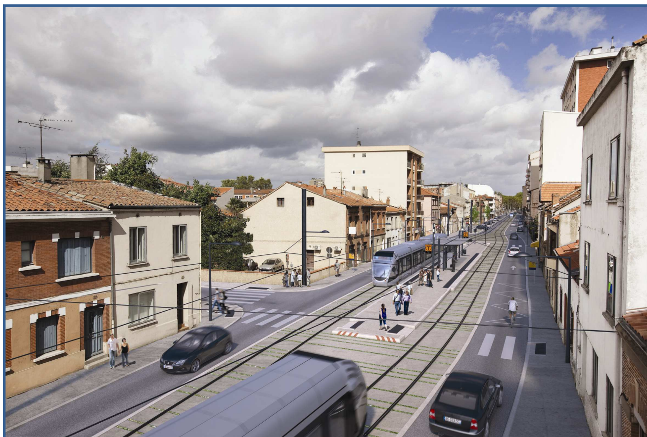
Station Avenue de Muret – Marcel Cavallé / fin 2013
