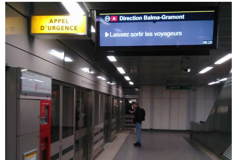
Installation d'un prototype sur les quais Ligne A (Station Arènes)
